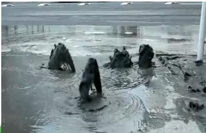
液状化した土の中で内部が空洞のマンホールは浮き上がります。
