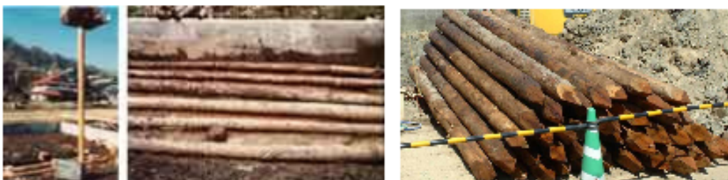
現在の松杭、昔の松杭の施工状況
