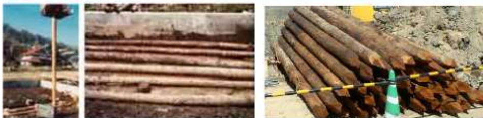
現在の松杭、昔の松杭の施工状況
