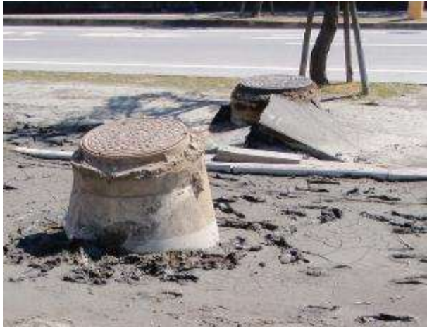
液状化した土の中で内部が空洞のマンホールは浮き上がります。
