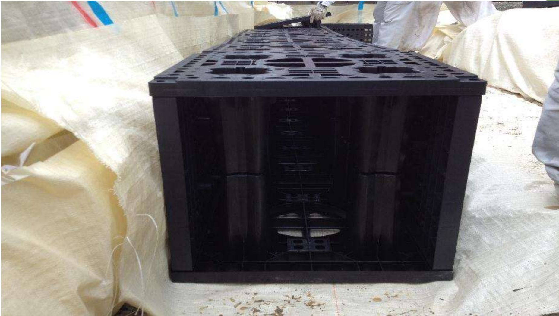
SG部材設置：両サイドのS Gに水糸を張り丁寧に並べる
