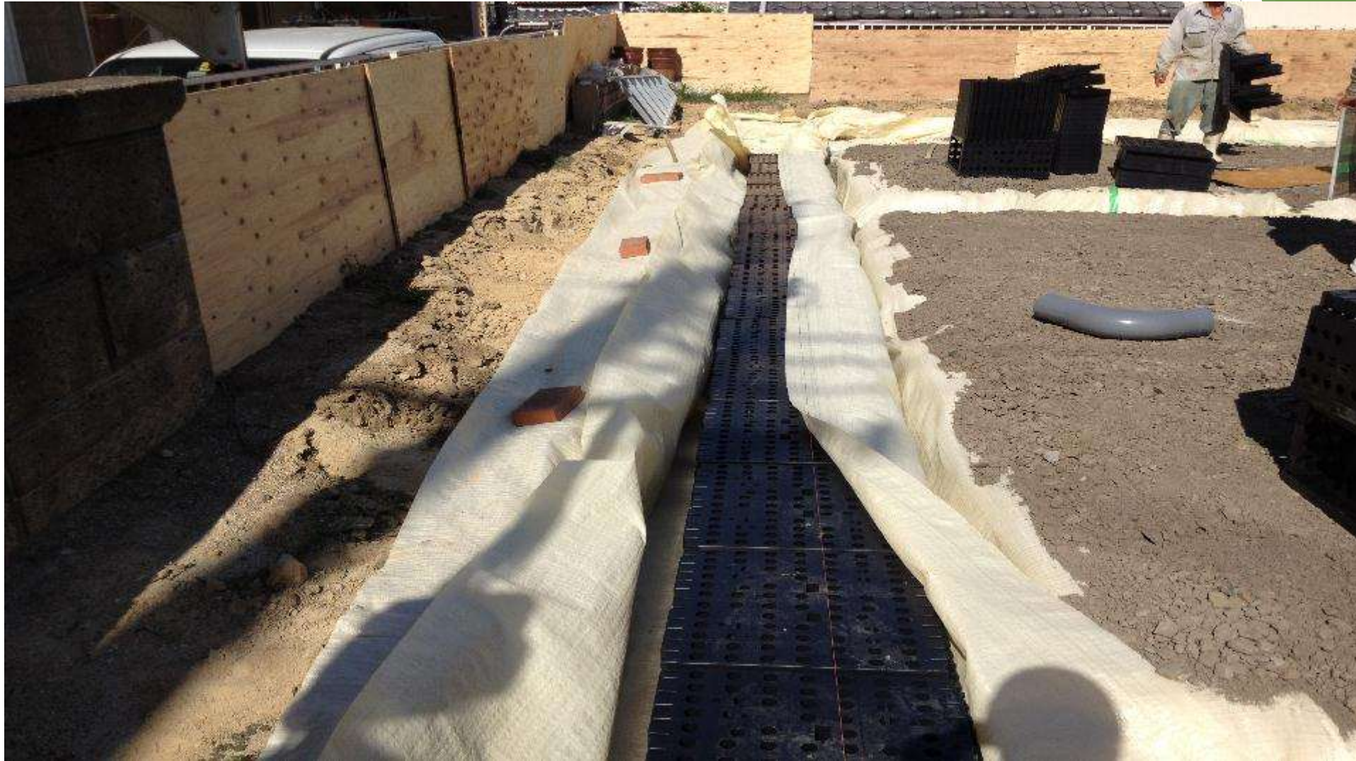
SG部材設置：両サイドのS Gに水糸を張り丁寧に並べる
